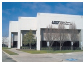
ユナイテッドスポーツテクノロジー・LP.
